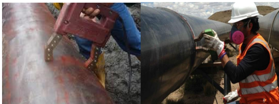
Ilustración 5 Inspección por partículas magnéticas
