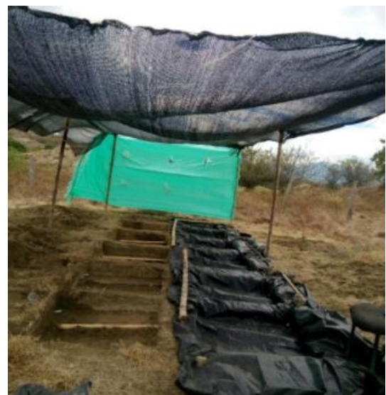
Ilustración 8. Montaje área landfarming
