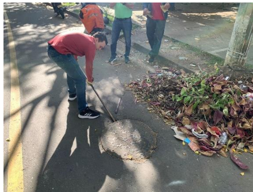
Figura 3-6: Apertura de pozos de inspección
