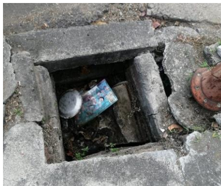
Figura 3-9: Sumidero suspendido para reposición.
