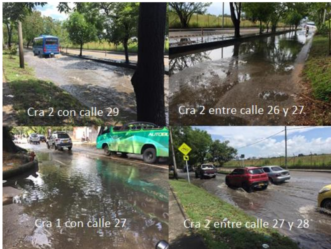
Figura 3-2: Puntos críticos donde se represan aguas lluvias en la zona de estudio.
