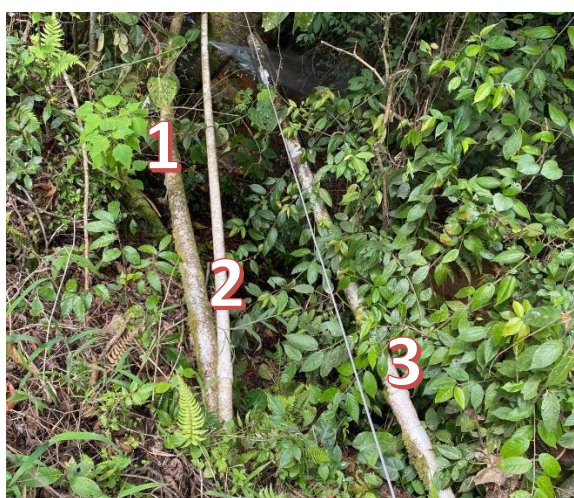
Figura 10. Tuberías salientes de la cámara de recolección.
