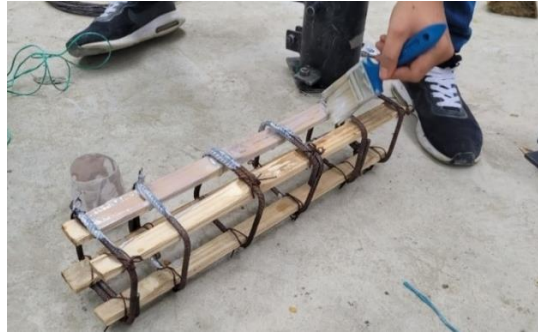
Figura 3-13: Aplicación de resina epóxica Sikadur – 32.
