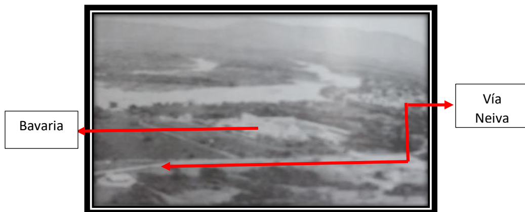
Figura 2 . Tramo inicial antigua instalaciones de Bavaria
