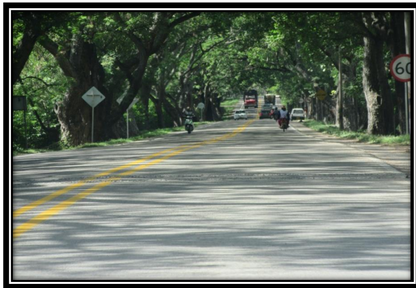
Figura 27. Estado de la señalización vial
