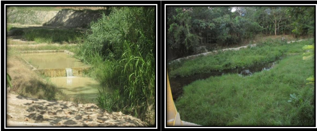
Figura 18. Represamiento y desvió del cauce del río
