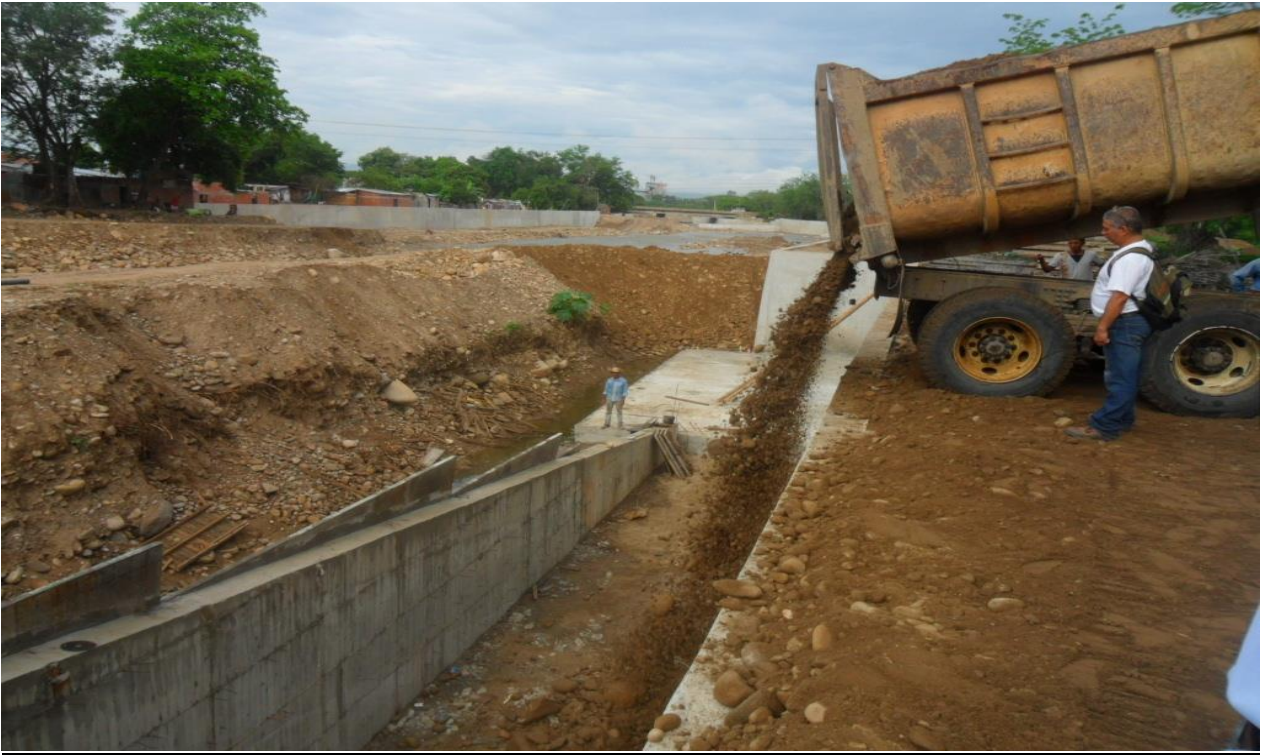
Ilustración 23: Relleno cajón rampa de acceso # 4 margen derecho
