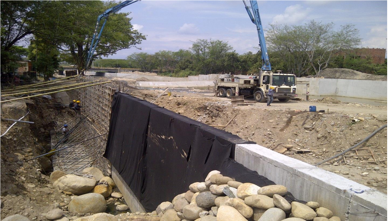
Ilustración 13 : Muro H=6,0 mts margen izquierda
