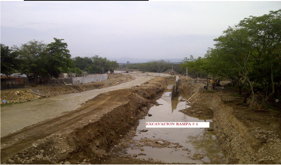
Ilustración 14: Excavación rampa acceso # 4 margen derecha
