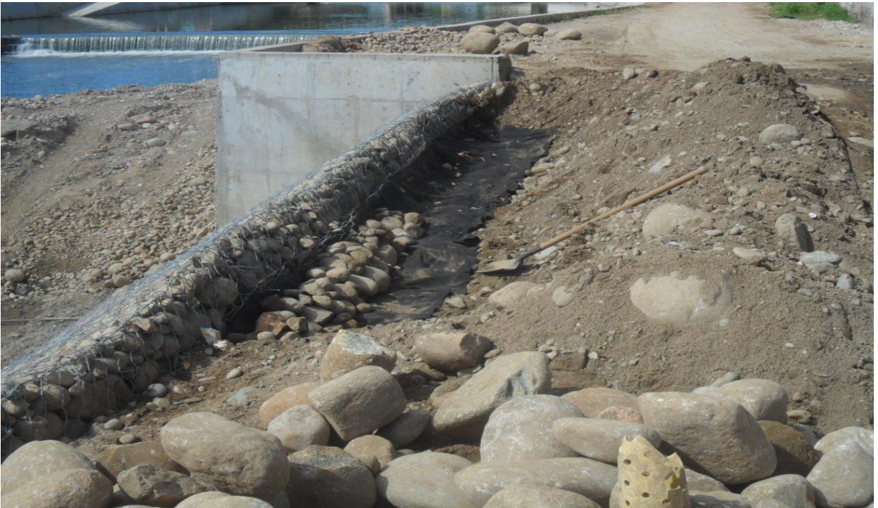
Ilustración 28: Filtro en geotextil no tejido
