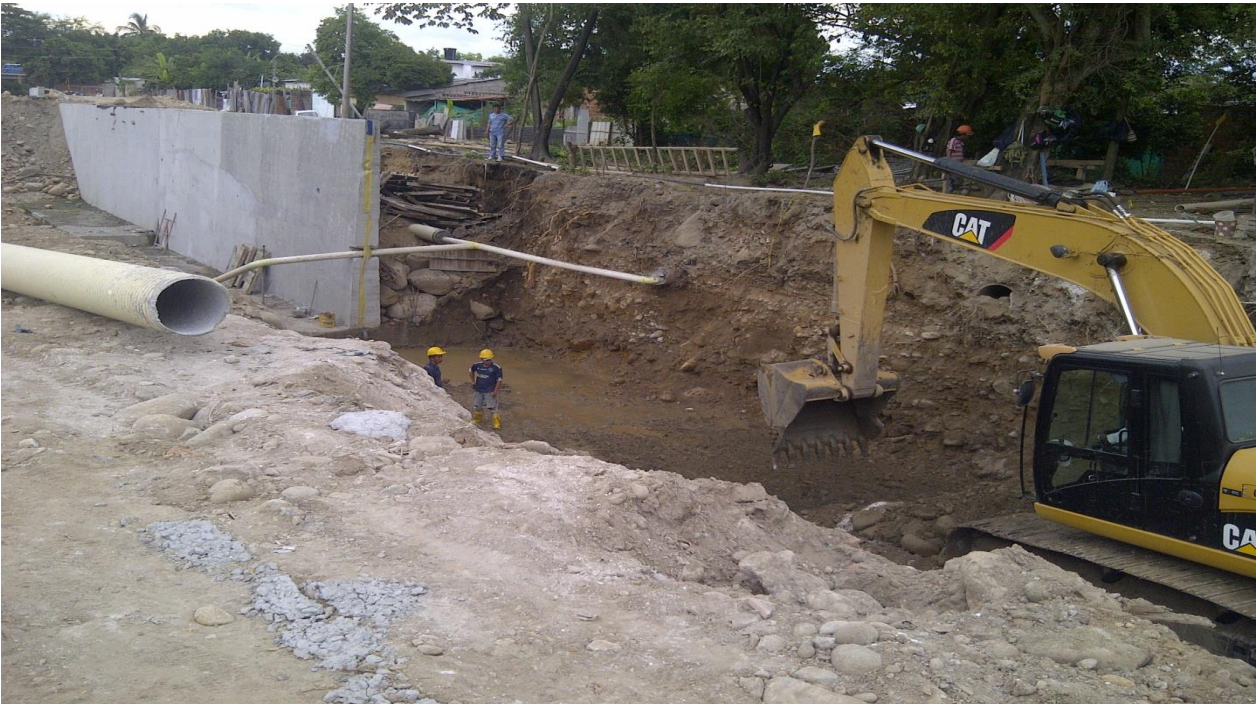
Ilustración 15: Excavación de muro H=6,0 mts margen izquierda
