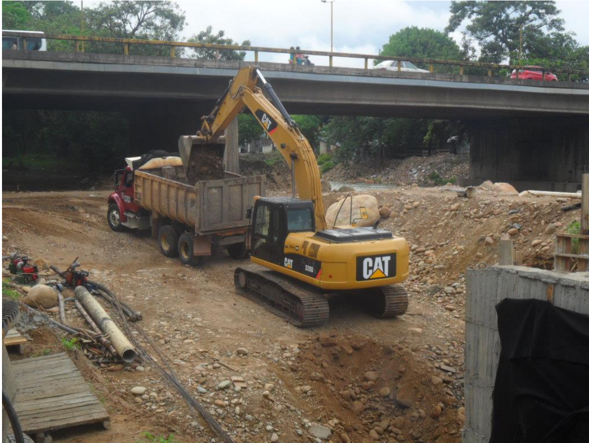
Excavación y cargue de material
