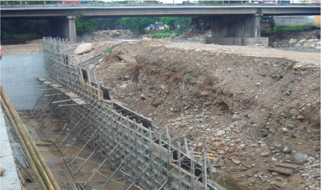
Ilustración 22: rampa # 4 margen derecha
