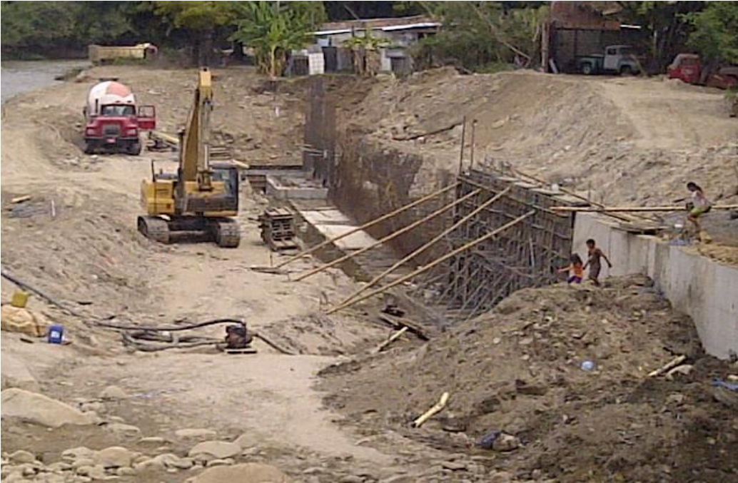
Ilustración 2 : Muro H=4,50 mts margen izquierda
