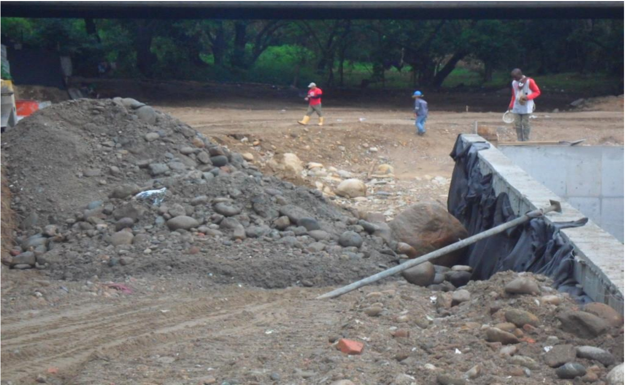
Ilustración 19: Relleno y colocación de filtro rampa # 4
