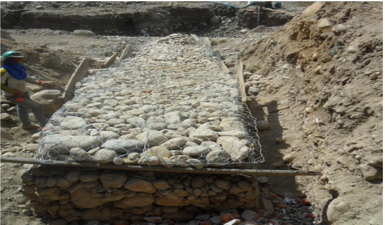
Ilustración 24: conformación gaviones tipo transversal # 1
