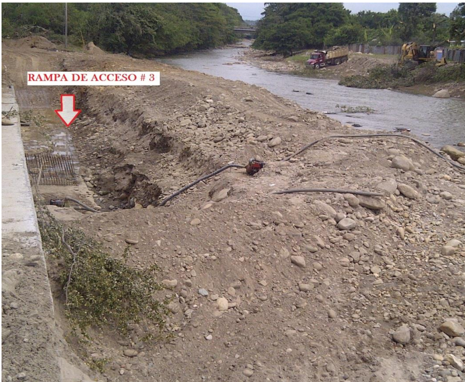
Ilustración 3: Construcción de rampa de acceso # 3
