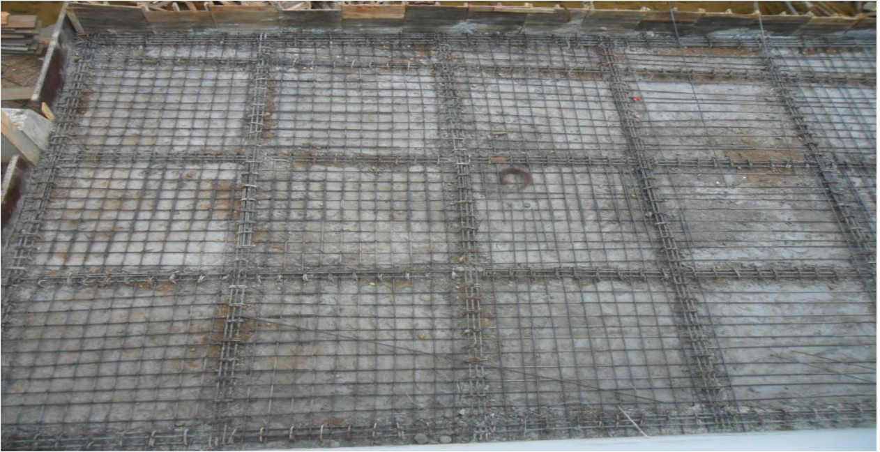
Ilustración 21 : Vigas plataforma inferior rampa # 4
