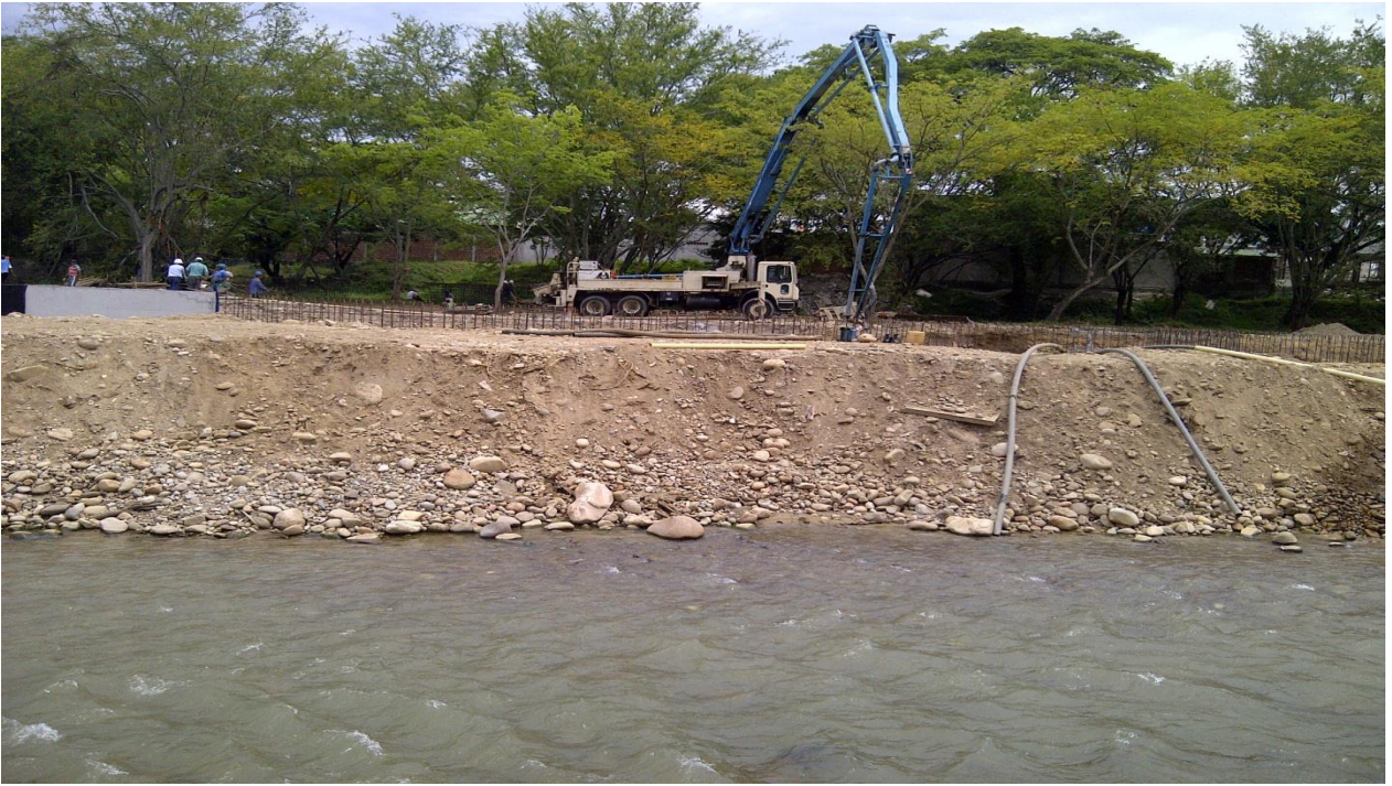
Ilustración 17: Funde zarpa h=5.50 mts margen derecha
