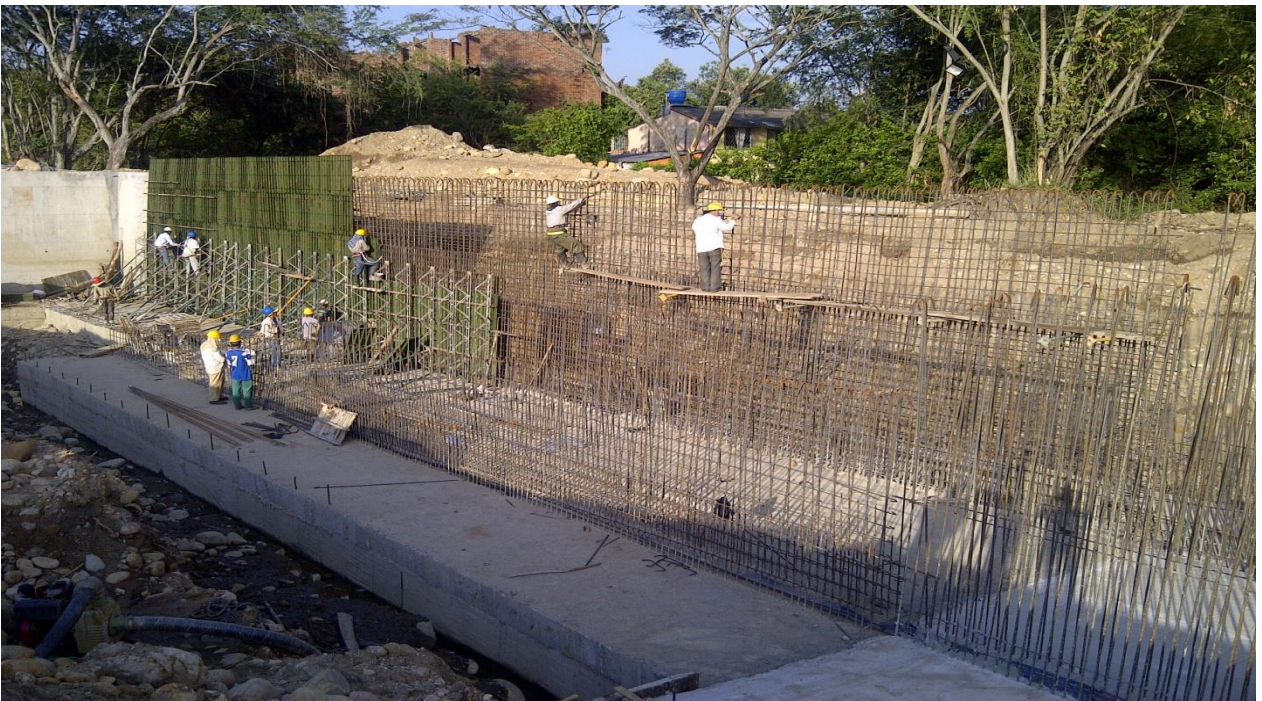
Ilustración 7: Amarre y formateo muro h=6,0 mts sección rampa de acceso #3
