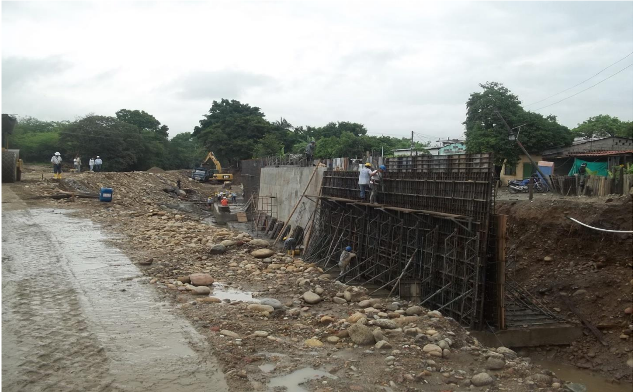
Ilustración 10: muros margen izquierda
