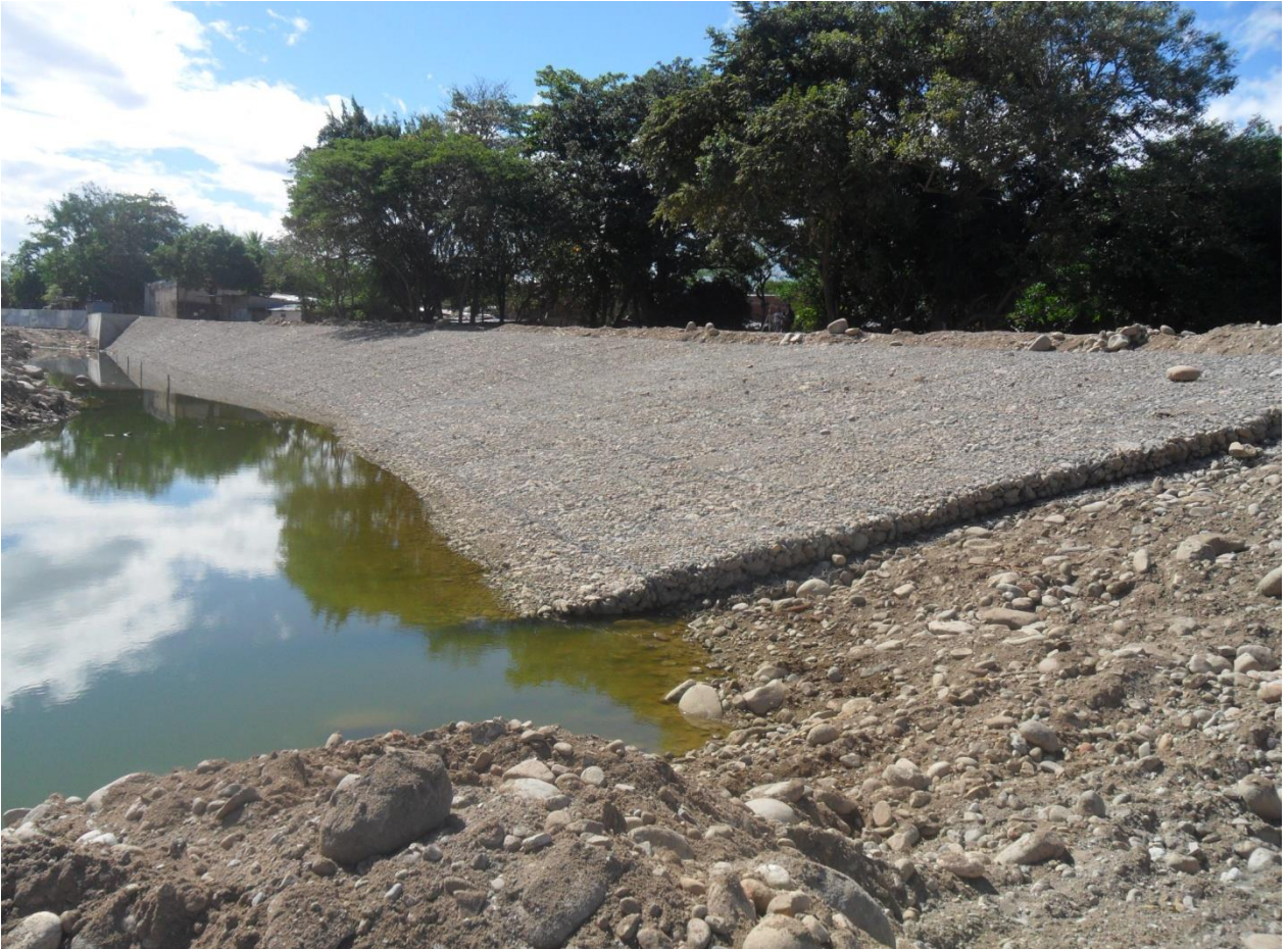
Ilustración 29: Trabajo final proyecto de COLCHOGAVIONES
