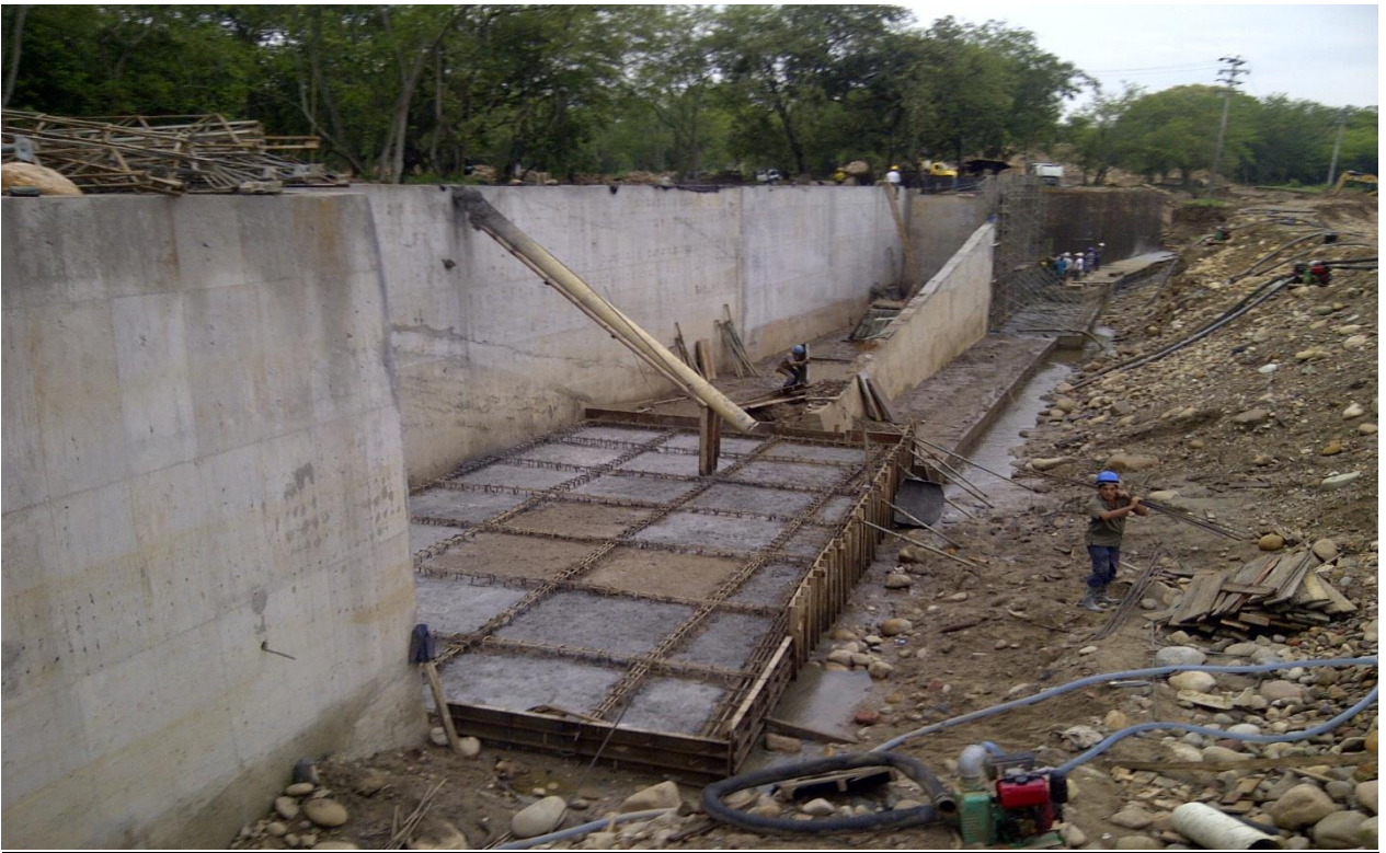
Ilustración 9: rampa de acceso # 3 viga placa inferior
