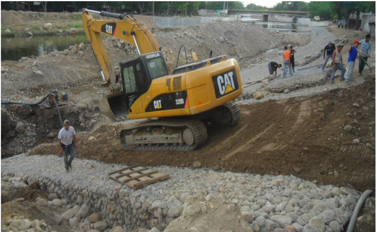
Ilustración 25: conformación de talud para COLCHOGAVION
