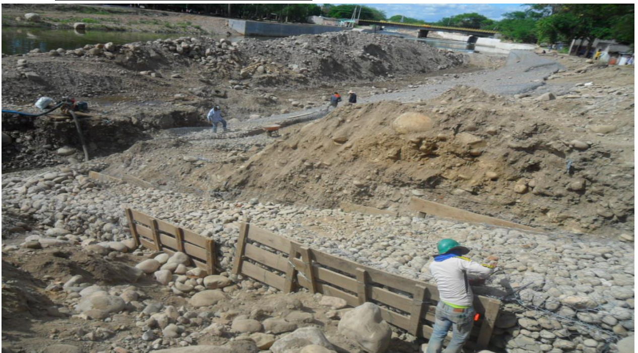
Ilustración 26: conformación y amarre de cuñas de transversales
