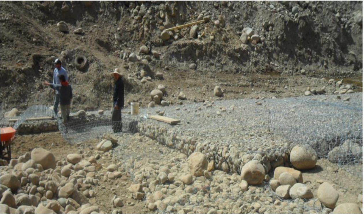
Ilustración 27: Conformación y amarre de COLCHOGAVIONES
