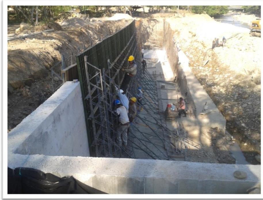
Construcción de muro lateral en el sitio de la rampa No 3
