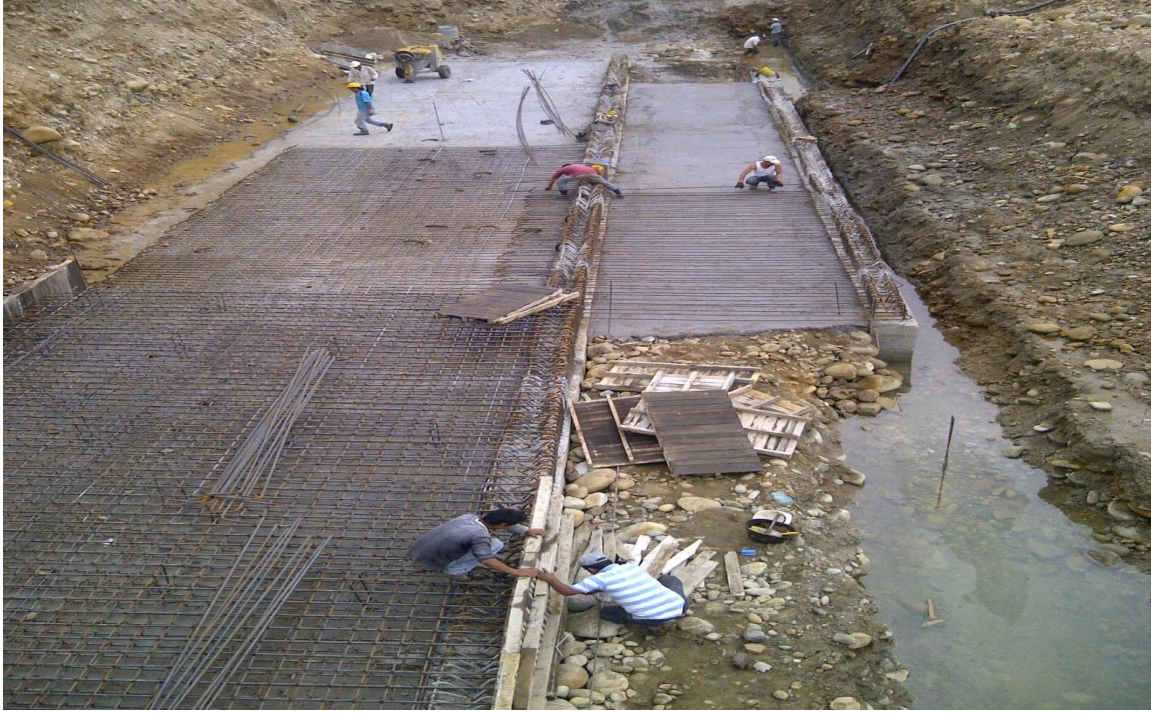
Ilustración 4: Zarpa muro H=6,0 mts sección rampa rampa acceso # 3 margen derecha
