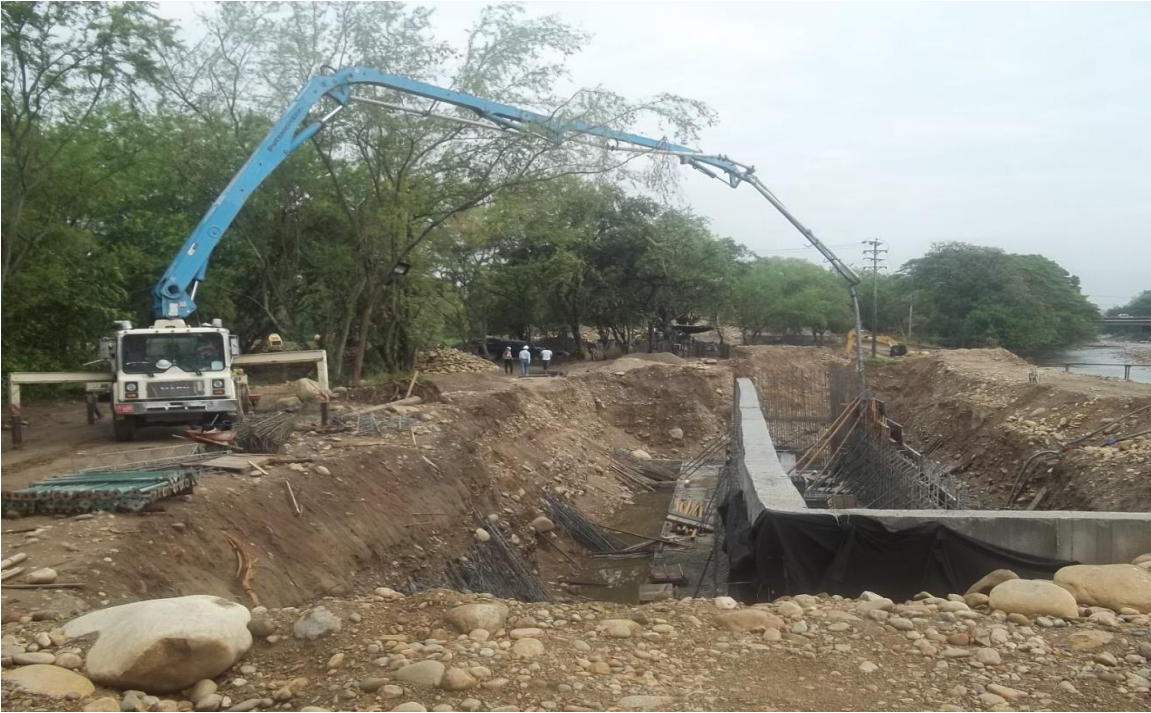
Ilustración 8: vaciar concreto 4000 P.S.I muro h=6 mts margen derecha rampa #3
