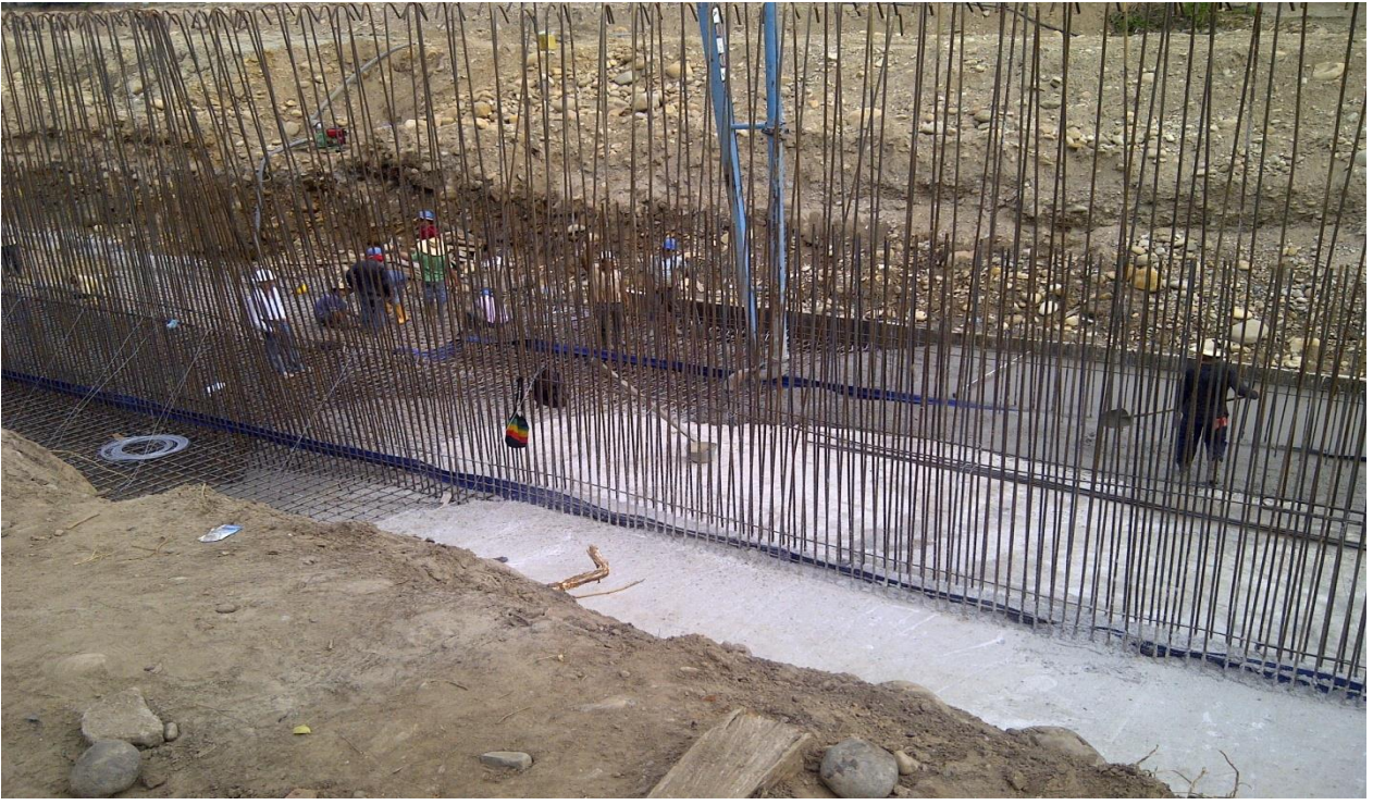
Ilustración 6: Funde placa inferior rampa de acceso # 3 margen derecho
